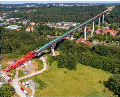
B 172n: Bau der Gottliebatalbrücke im Zuge der Ortsumgehung Pirna (Sachsen)
