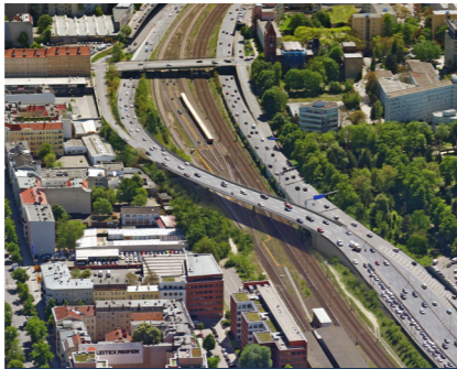
A 100: Visualisierung des Ersatzneubaus der Westendbrücke (Berlin)
