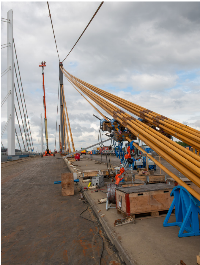
Die ersten Schrägseile werden mit einem speziellen Litzenhubsystem präzise gekappt
