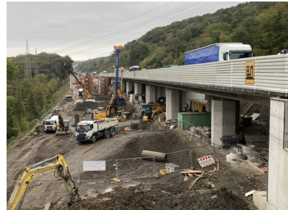
Oktober 2020: Blick auf die Baustelle
