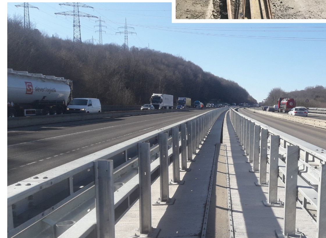
Juni 2022: Die neue Talbrücke ist vollständig in Betrieb
