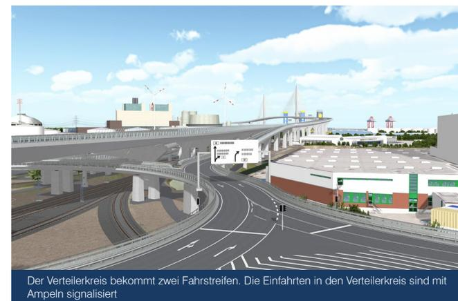
Der Verteilerkreis bekommt zwei Fahrstreifen. Die Einfahrten in den Verteilerkreis sind mit Ampeln signalisiert
