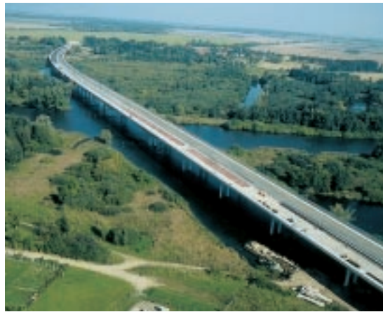
Die Peenebrücke bei Jarmen kurz vor ihrer Fertigstellung.
