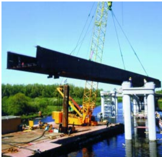
Einschwimmen des Stahltroges.
