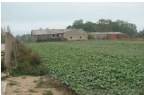
Stallobjekt Zienkendorf vor und nach dem Rückbau (Rückführung in Ackernutzung).
