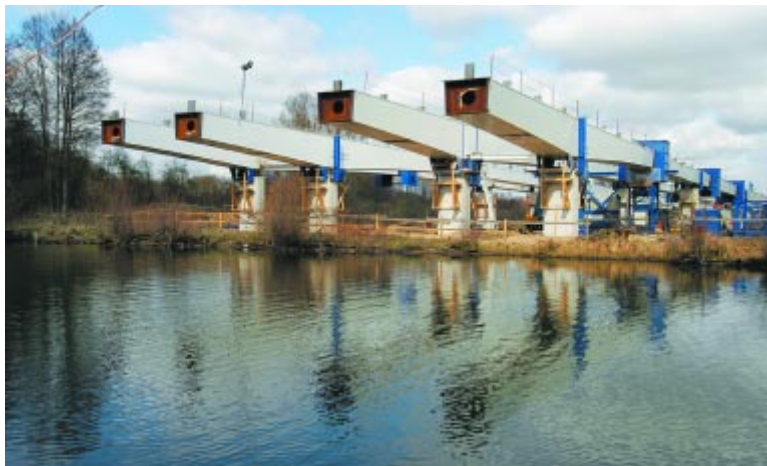
Die Stahlträger der Überbauten kurz vor dem großen Brückenschlag über die Wakenitz.
