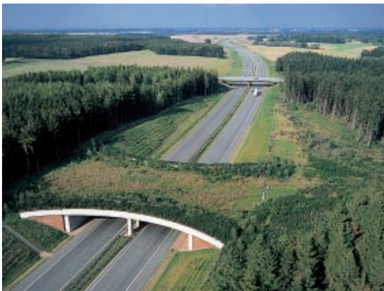
Der Bau von Grünbrücken (hier bei Bobitz) mindert die Zerschneidungswirkung der Autobahn für die Tierwelt.
