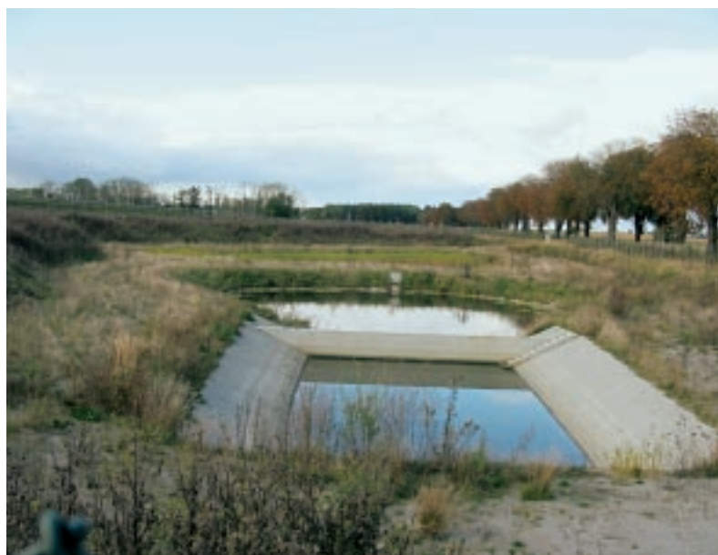
Absetzbecken mit Tauchwand und dahinter naturnahes Regenrückhaltebecken.
