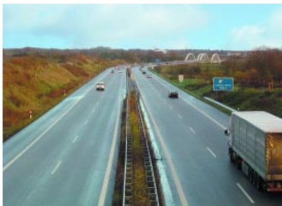
Fertiggestellter Abschnitt mit der Brücke über den Elbe-Lübeck-Kanal im Hintergrund.
