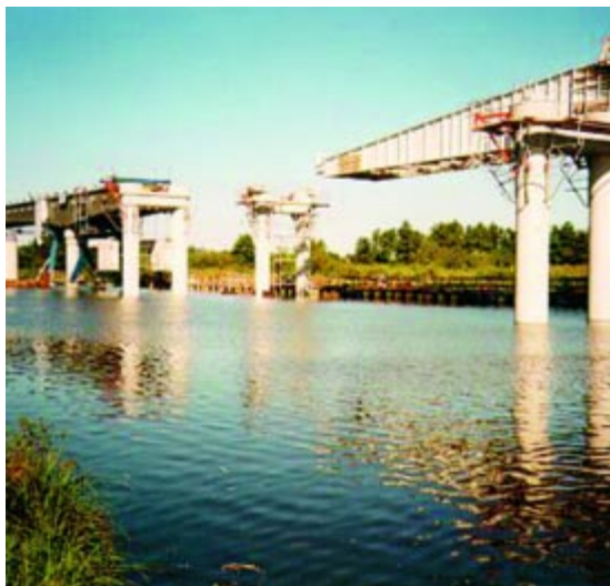
Brückenschlag zwischen Vorland- und Strombrücke.
