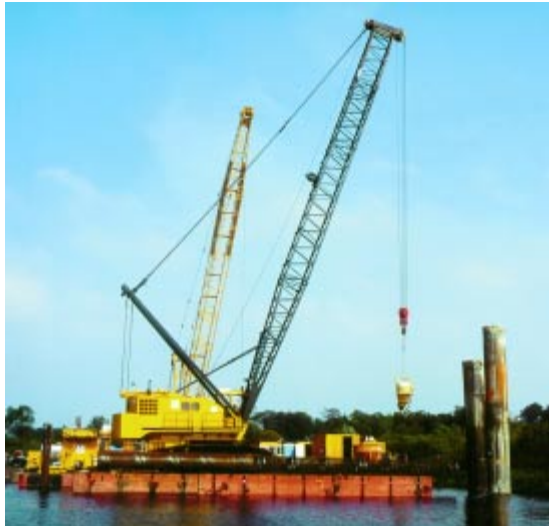
Pfahlherstellung vom Ponton aus.
