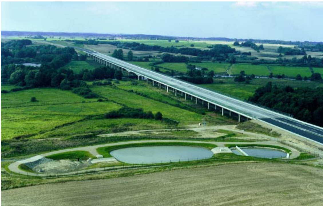
Wasserbehandlungsbecken an der Warnowbrücke.
