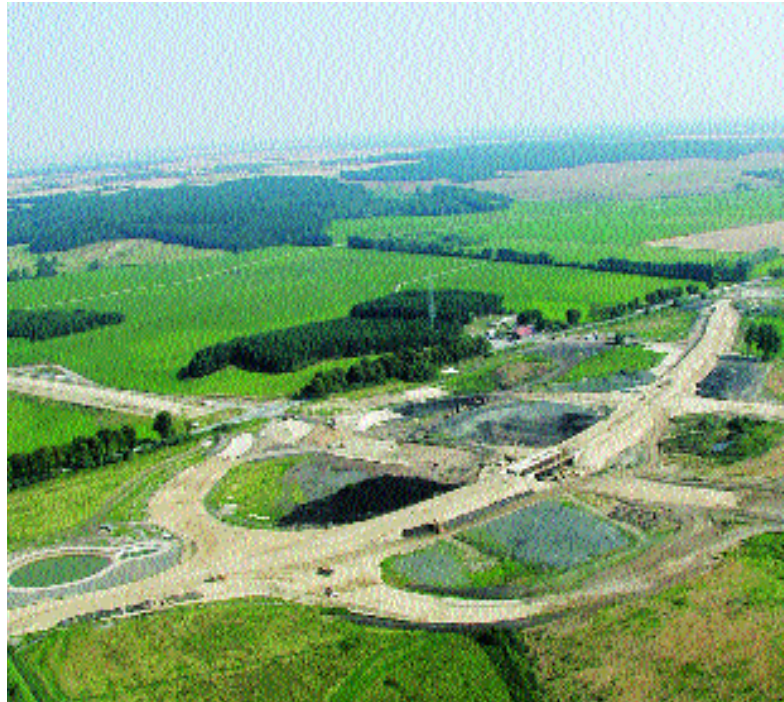
In Form eines vierblättrigen Kleeblattes ausgebildet die AS Neubrandenburg-Ost während der Bauphase.
