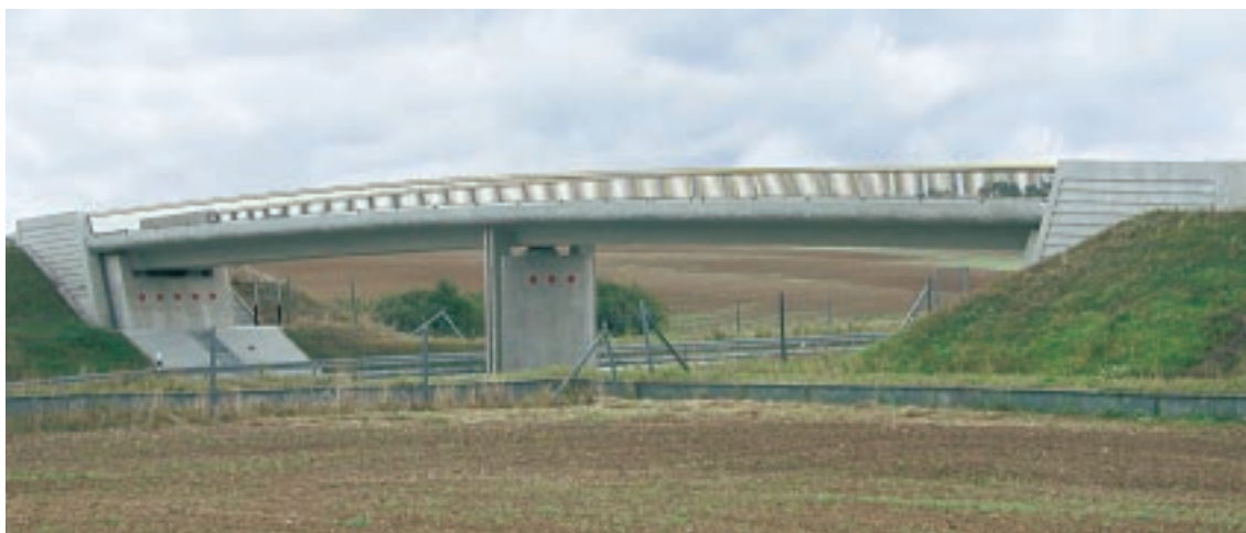
Überführungsbauwerk mit den für den östlichen Gestaltungsabschnitt typischen Stilelementen.
