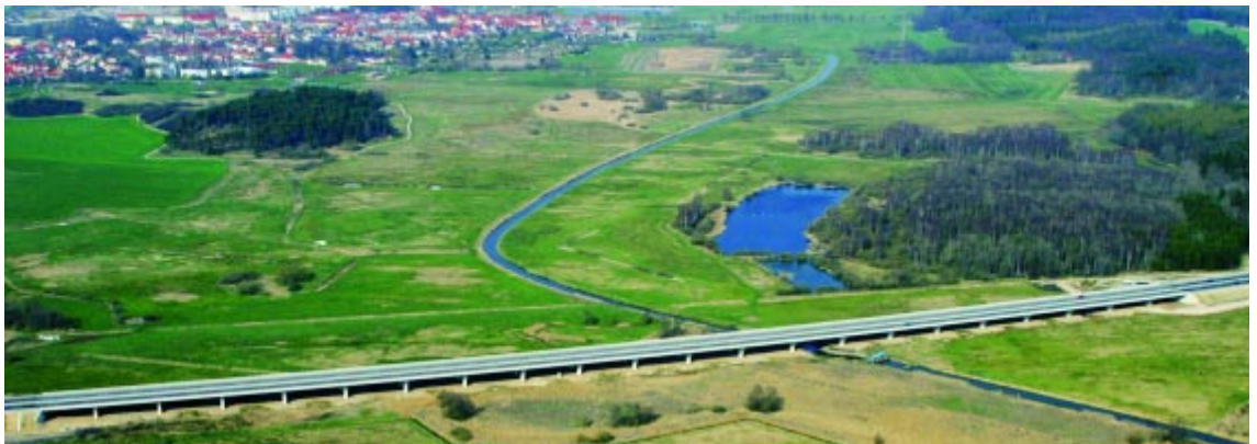
Die Recknitztalbrücke mit der Stadt Tessin im Hintergrund.
