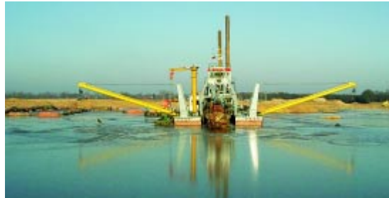
Schwimmbagger in der Seitenentnahme.
