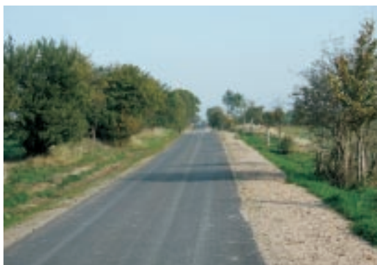
Ein Hauptwirtschaftsweg vor und nach der Ausbaumaßnahme.
