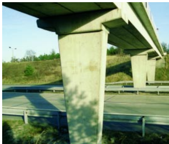
Überführungsbauwerk in „industrieller Fertigteilm Bauweise“ an der DDR-Autobahn Rostock–Berlin (aufgenommen 1988).
