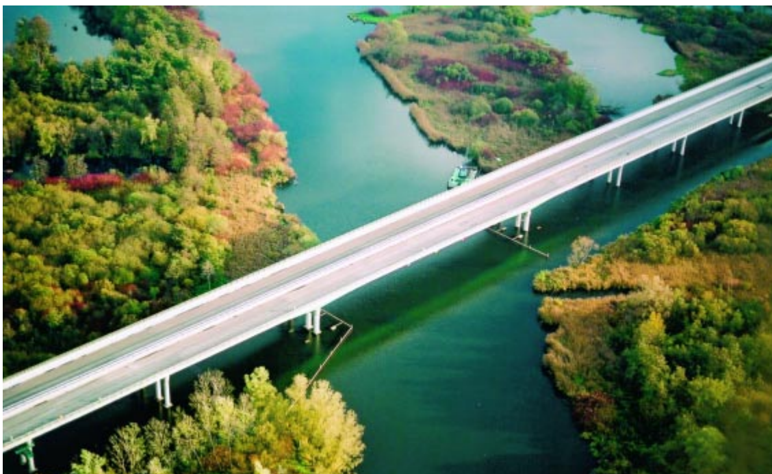
Das fertiggestellte Bauwerk im Einklang mit seiner natürlichen Umgebung.
