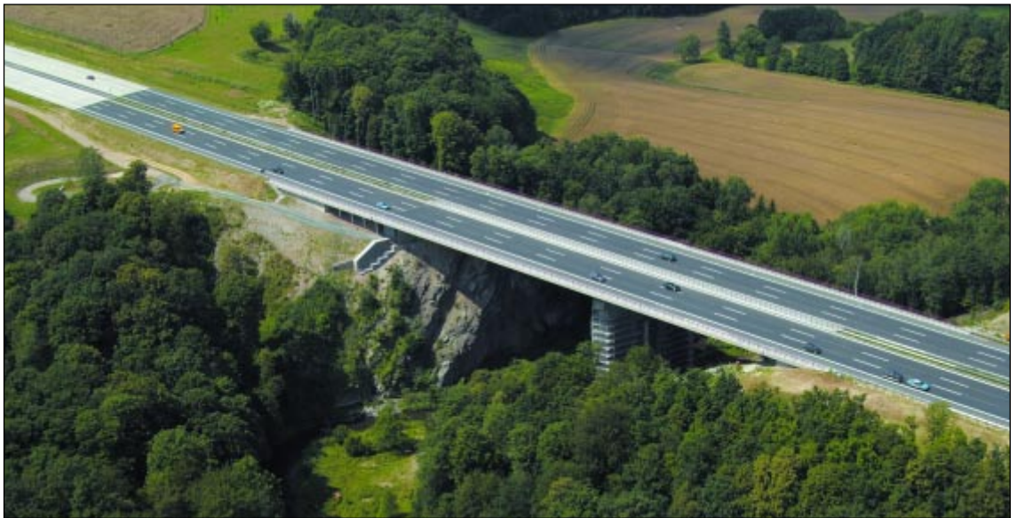
Talbrücke Große Striegis.
