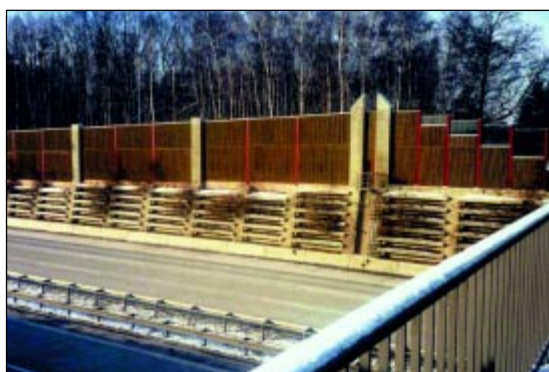
Lärmschutzwand mit Bepflanzung und Anschluß an eine Überführung bei Auerswalde.
