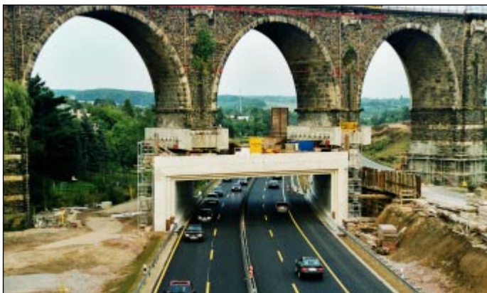
Das Unterfan- gungsbau- werk auf der Nordseite nach Been- digung der 1. Bauphase.
