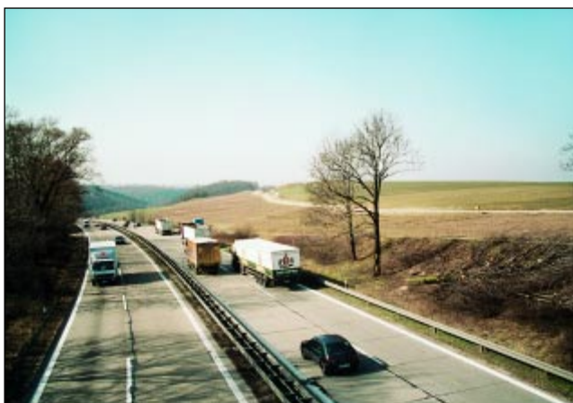
Die alte Trasse kurz vor dem „Tanneberger Loch“.
