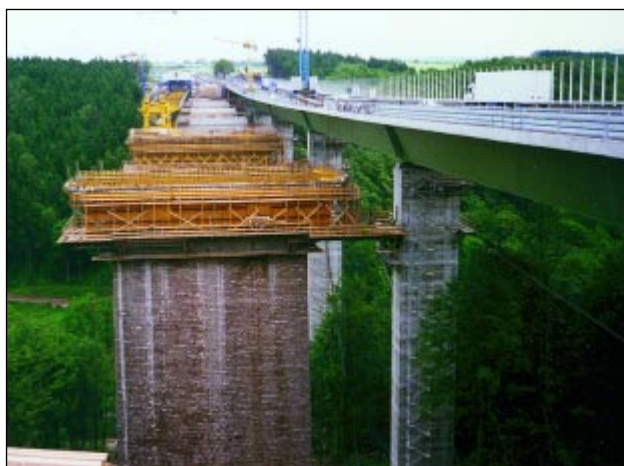
Herstellung der neuen Pfeilerköpfe.
