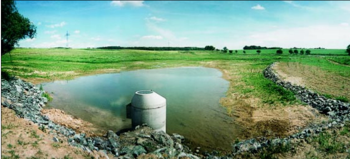
Vor Durchführung der Maßnahme.
