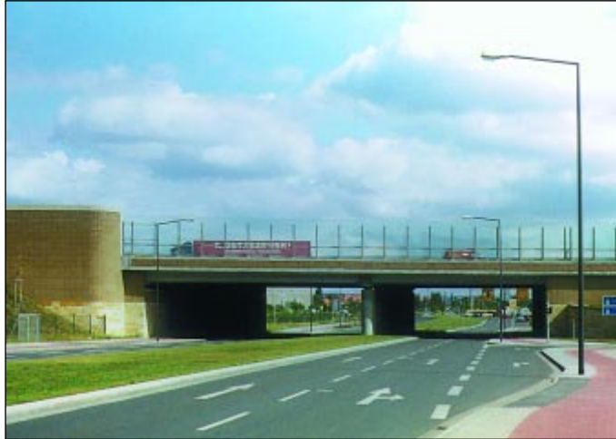
Dresden-Neustadt: Unterführung der Stadtstraße.
