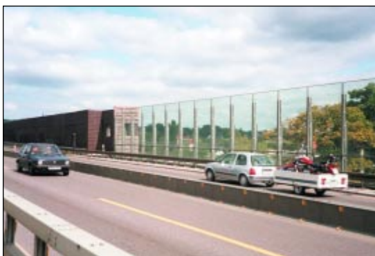
Transparente Lärmschutzwand auf einer Brücke.
