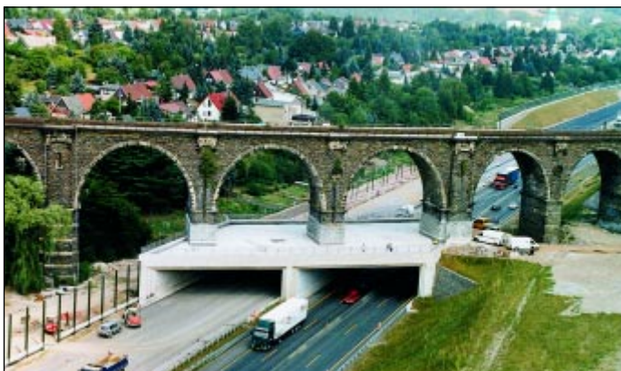
Das fertig- gestellte Bau- werk: eine ge- lungene Sym- biose aus alter und neuer Archi- tektur.
