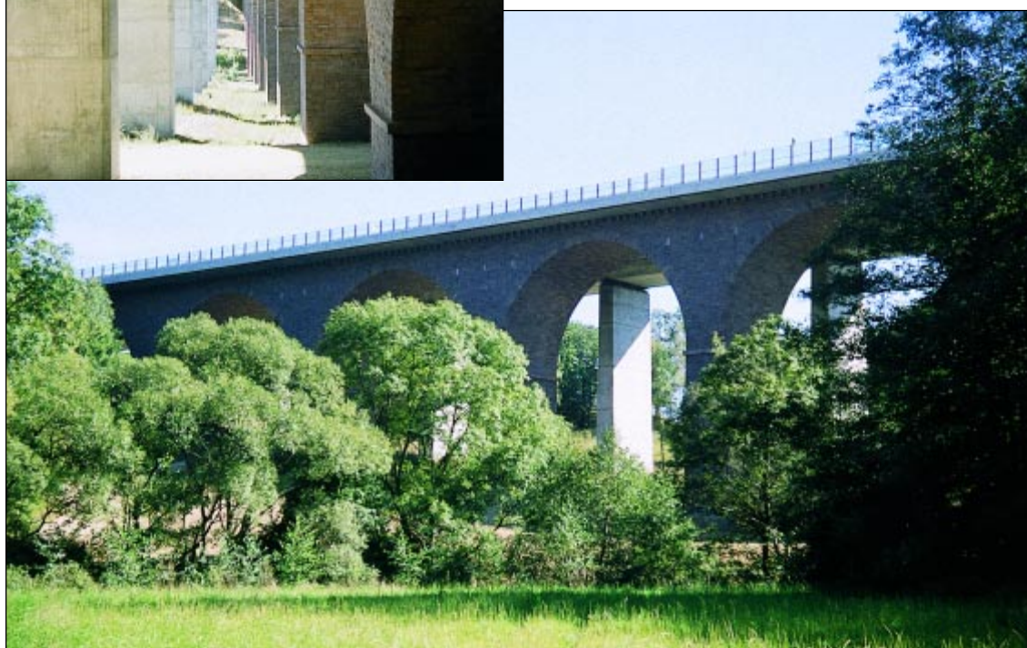
Harmonisches Nebeneinander von Gewölbereihe und Betonpfeiler. Unteransicht des Bauwerks (kl. Foto).
