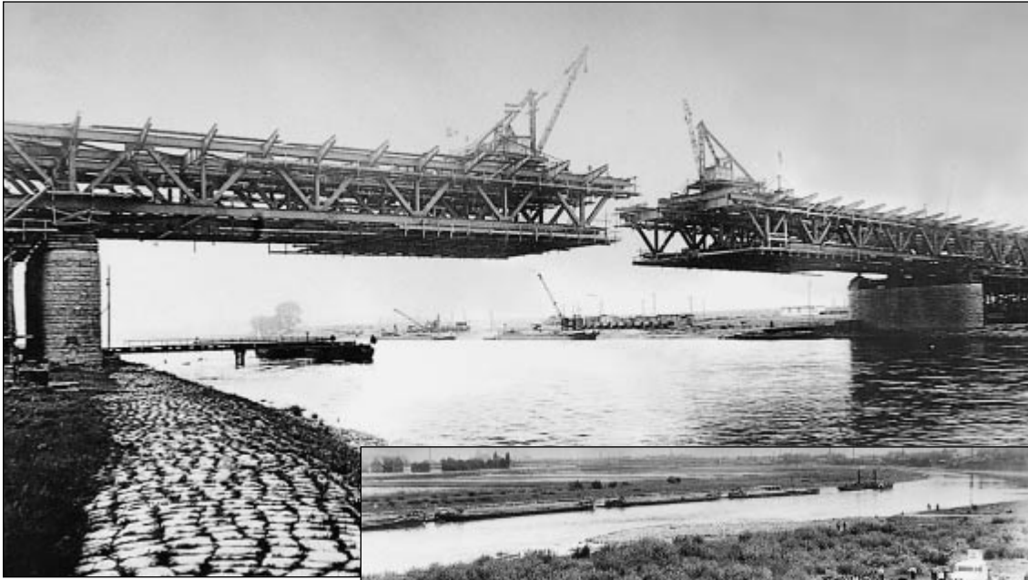
Der Überbau der historischen Elbebrücke Dresden kurz vor Brückenschlag im Jahr 1935.
