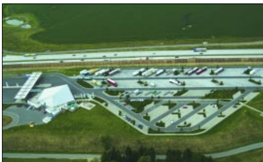
Tank- und Rastanlage Auerswalder Blick.
