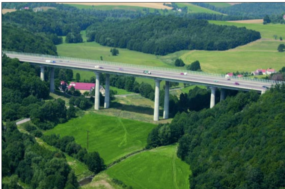
Das fertiggestellte Bauwerk wirkt besonders schlank und durchlässig.
