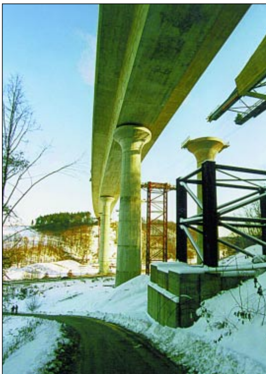
Winterliche Baustelle: Ein Überbau ist fertiggestellt, der andere wird gerade eingeschoben.
