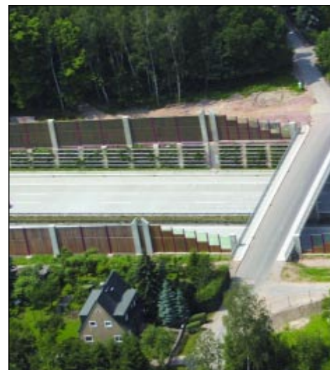
Umfassender Lärmschutz in Siedlungsnähe, hier am nördl. Stadtrand von Chemnitz.
