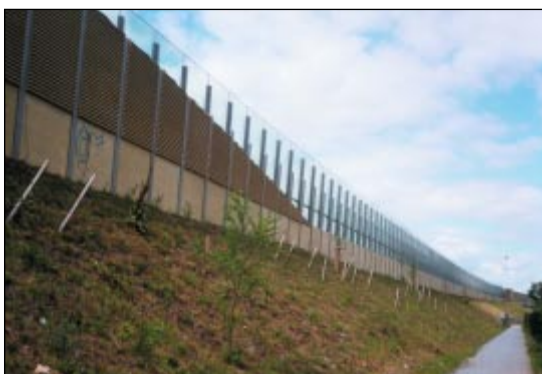
Lärmschutzwand/-wand auf der Anliegerseite bei Dresden-Neustadt.
