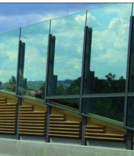
Lärmschutzwand bei Dresden-Neustadt: Übergang zwischen Glas und Beton.
