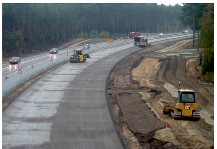
Einbau hydraulisch gebundener Tragschichten, Bauende
