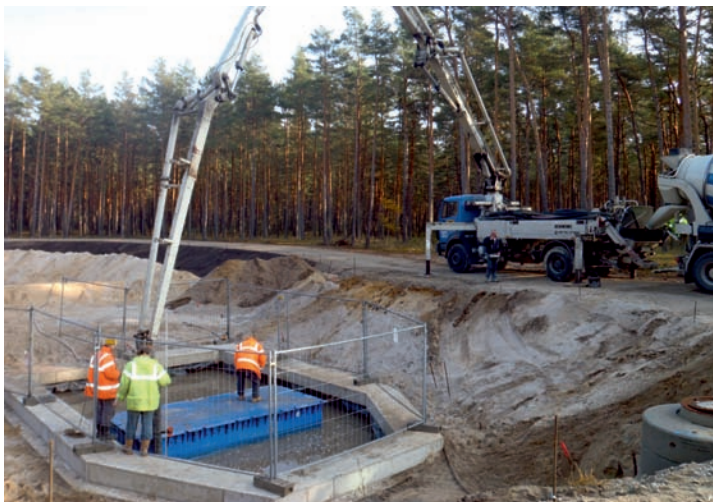
Wasserundurchlässiger Beton, Sickerbecken
