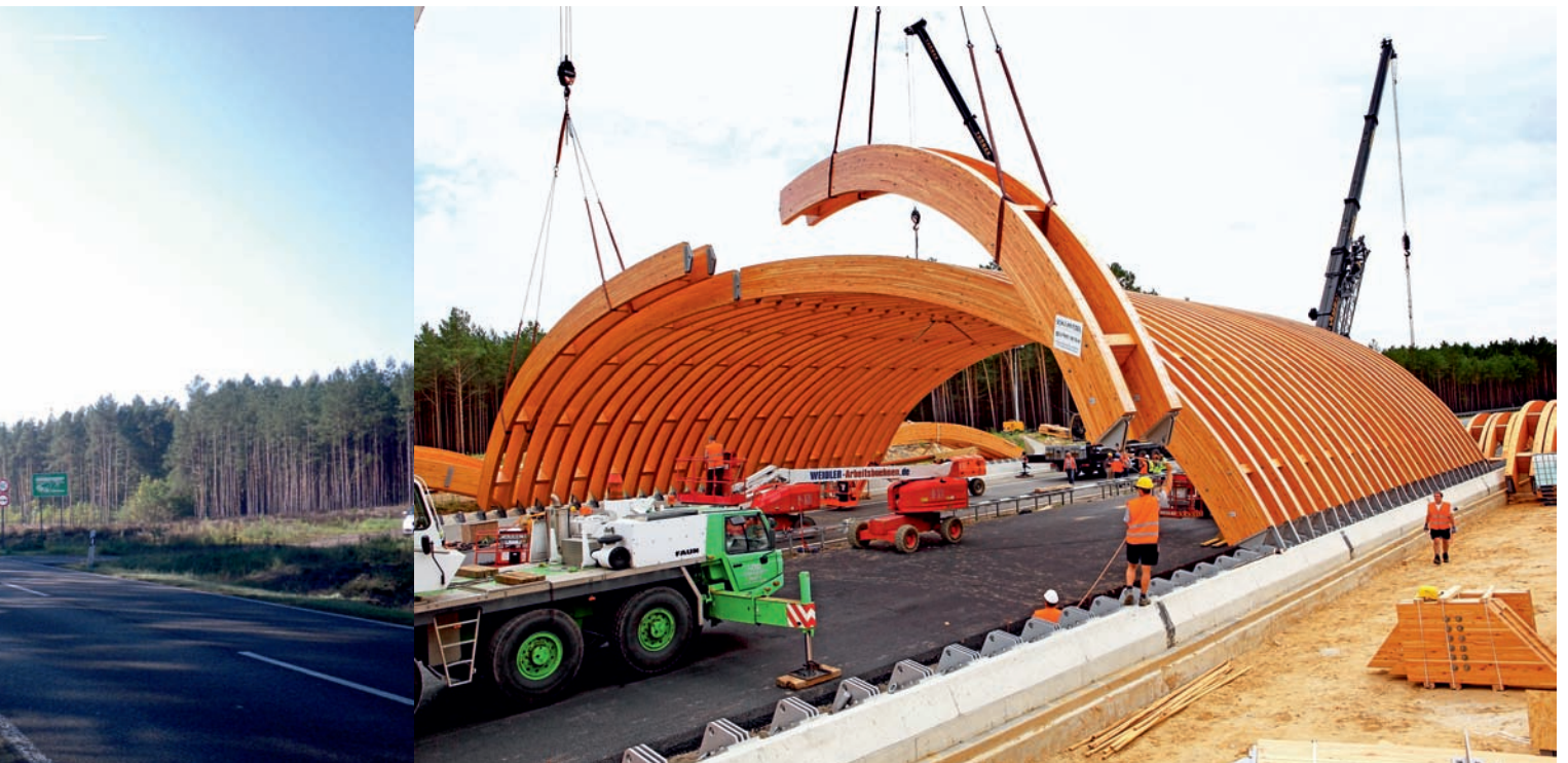
Grünbrücke in Holzbauweise
