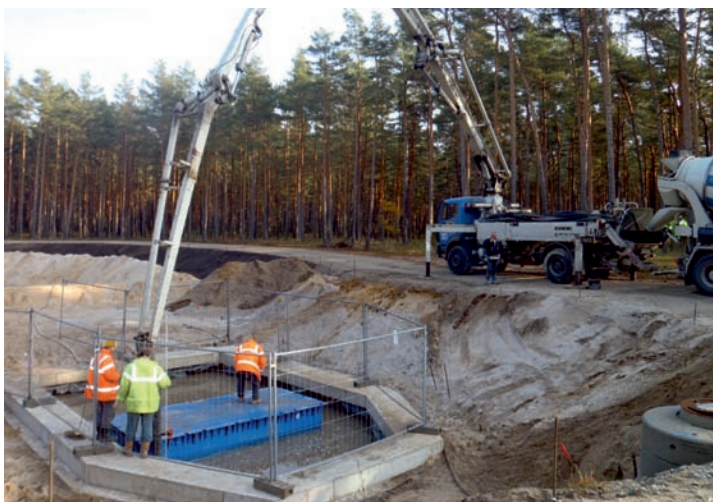
Wasserundurchlässiger Beton, Sickerbecken
