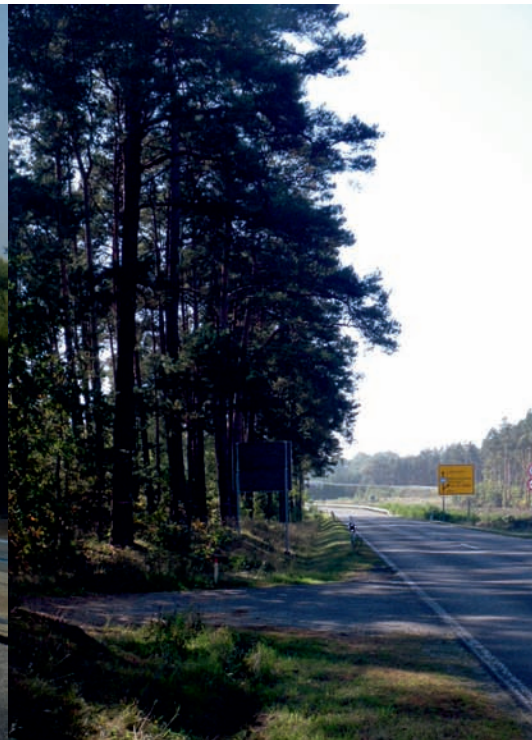
Bauende bei Woltersdorf
