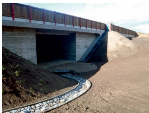
Wildunterquerung - Richtungsfahrbahn Trebbin
