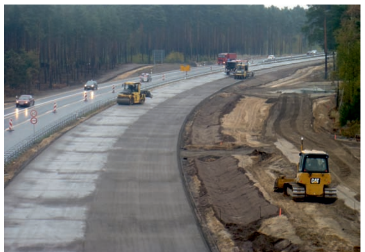
Einbau hydraulisch gebundener Tragschichten, Bauende
