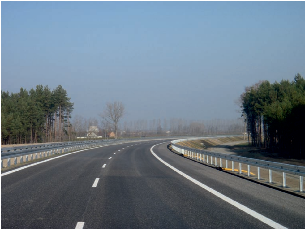
Fertiggestellter Streckenabschnitt Richtungsfahrbahn Trebbin
